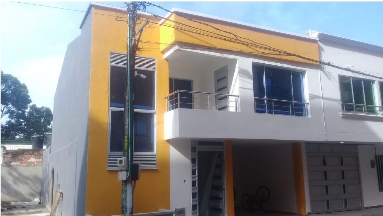
Construcción en sitio propio- Trabajador Javier córdoba finca Taiwán
